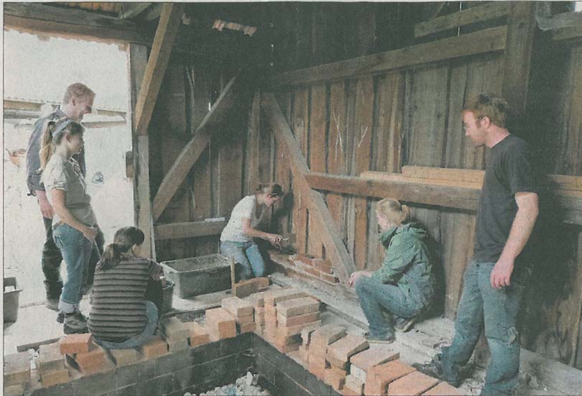
Studierende von der Staatlichen Akademie der Bildenden Künste Stuttgart lernen beim Ausmauern eines Fachwerk-Gefaches mit dem Romancement die Verarbeitung des alten Baustoffs. Fotos: Munzinger
